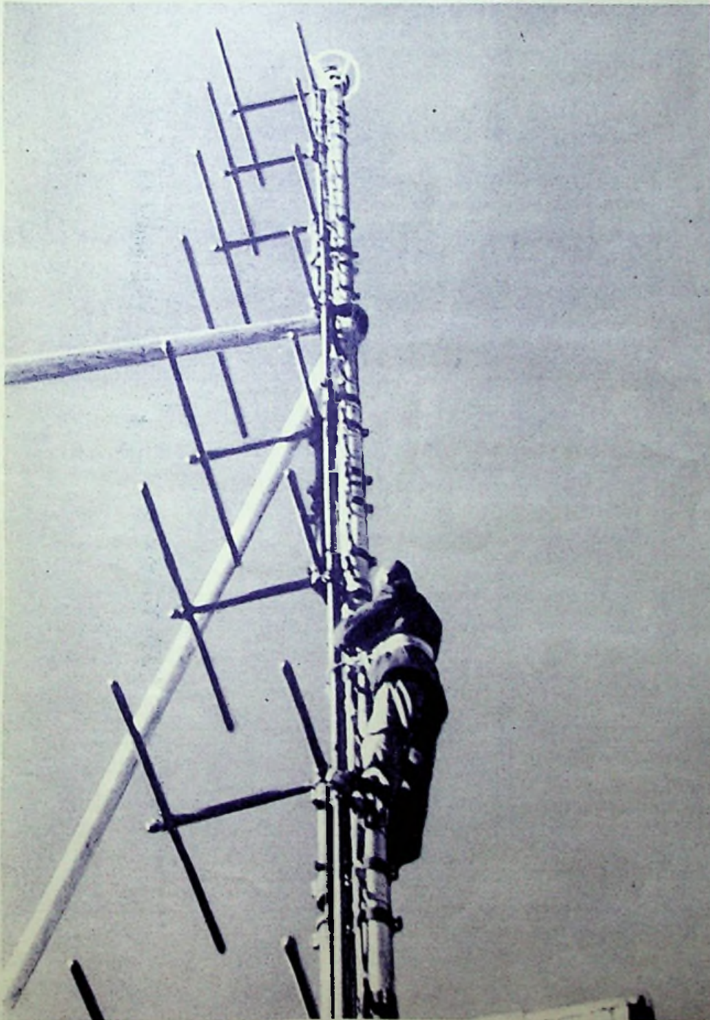
Auf dem Wendelstein wurde zur Erhöhung der vertikalen Bündelung und der Empfangsfeldstärke eine neue, von der Firma Rohde & Schwarz gebaute 8fach-UKW-Dipol-Reflektor-Antenne aufgestellt. Der Wendelstein-Sender überträgt das Programm des Bayerischen Rundfunks auf 89,3 MHz. (Foto: Kreis).
